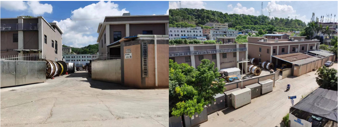
材料、设备储存仓库
