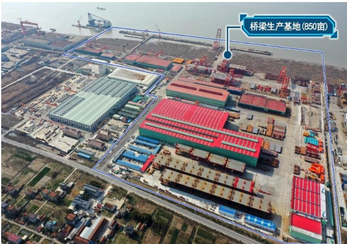
启东（京沪重工）基地照片
