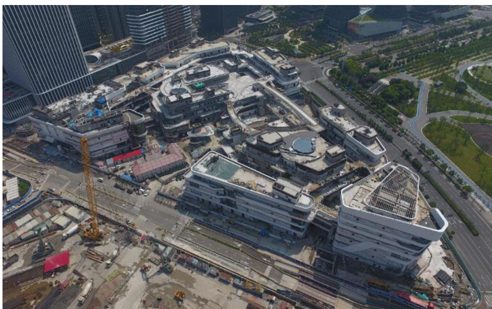
主体结构施工
