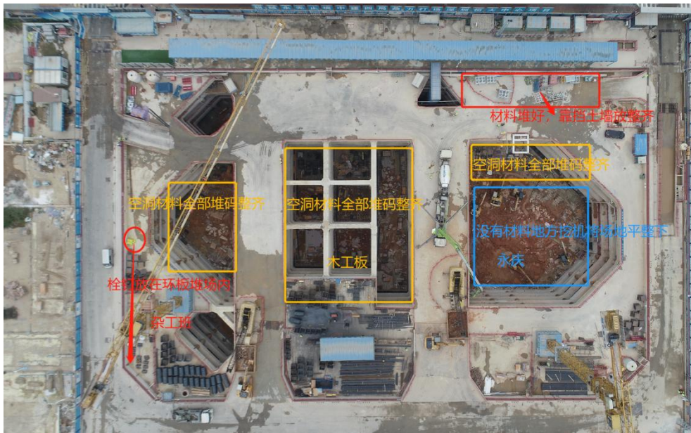
第六层土方开挖施工现场图
