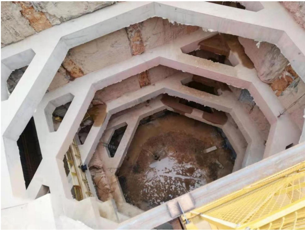
关口渠结合井基坑施工现场照片
