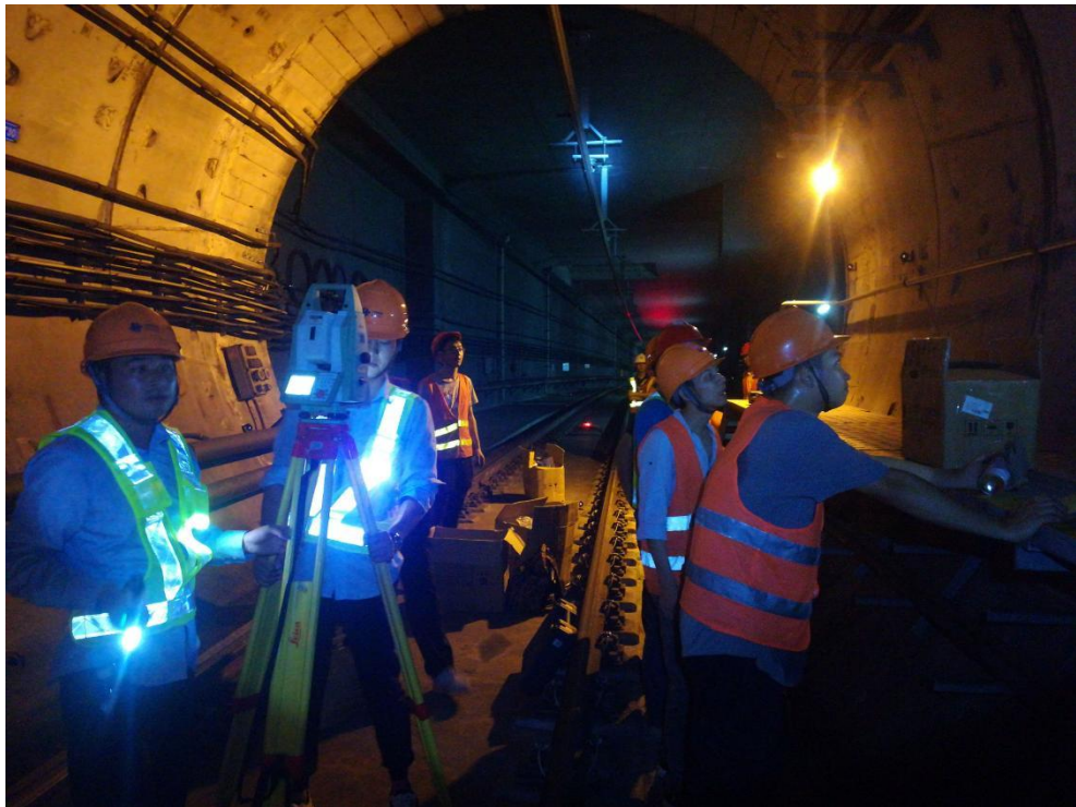
地铁隧道自动化监测现场调试
