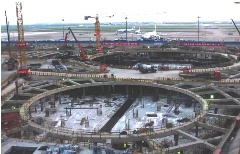
卫星厅底板形成施工现场照片
