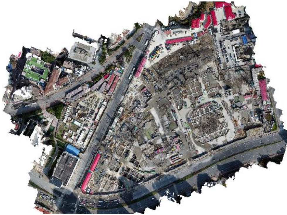
基坑施工航拍图
