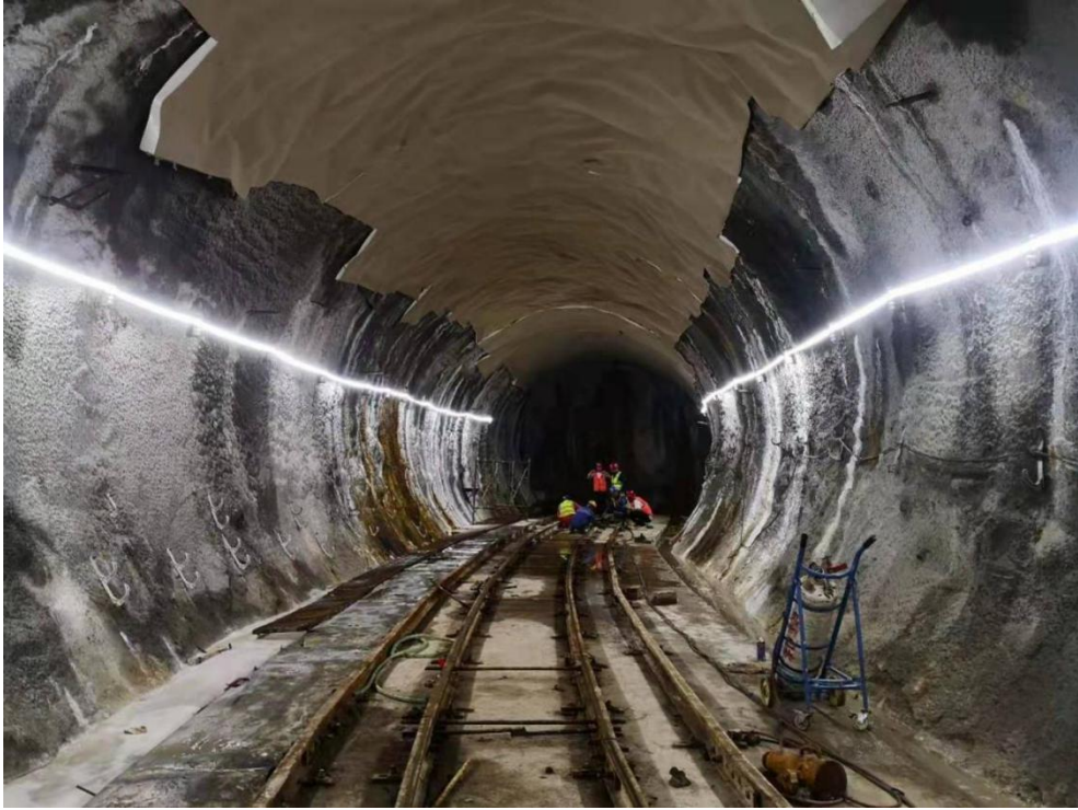
主隧矿山法段施工现场照片
