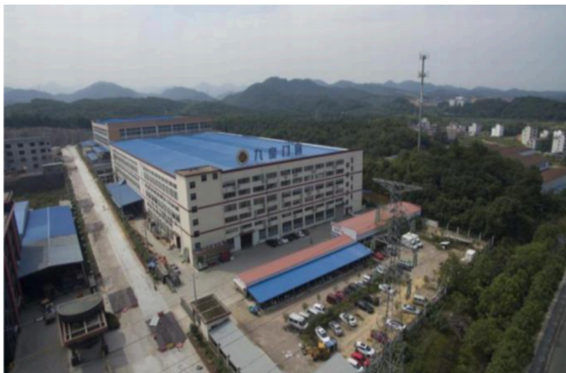
附件 2 工厂实景图片
