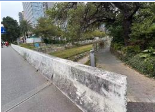
防撞墙破损脏污
