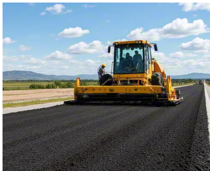
沥青混凝土摊铺
