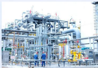
上饶高新区天然气利用项目设备及管道安装工程
