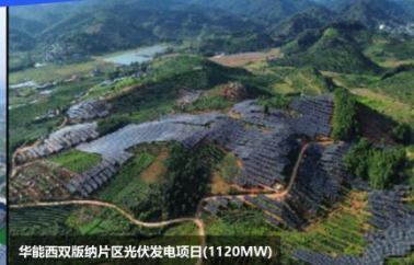
华能西双版纳片区光伏发电项目(1120MW)
