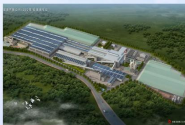
萍乡市安源玻璃有限公司1200吨/日玻璃项目
