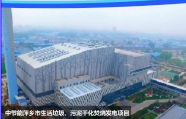
中节能萍乡市生活垃圾、污泥干化焚烧发电项目
