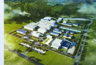
中核沽源铀业有限责任公司水冶综合技改项目
