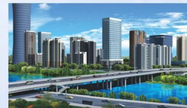
赣州市南康区东山路北延二期工程
