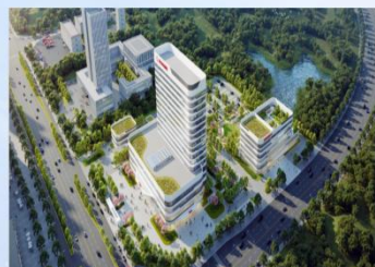
萍乡市儿童医院和托育综合服务中心建设项目
