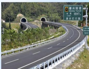
德兴隧道（德兴东-龙头山-大青山） 交通基础设施建设
