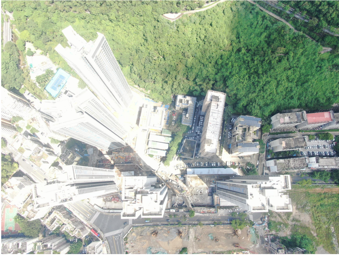
项目主体施工航拍图
