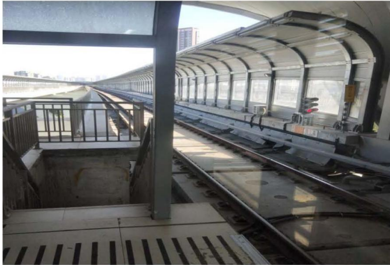
地铁现场实景
