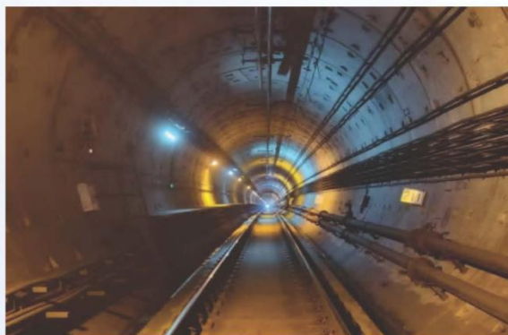
基坑监测-深圳地铁运营监测
