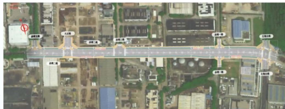
赤湾二路（赤湾五路至左炮台路段）工程
