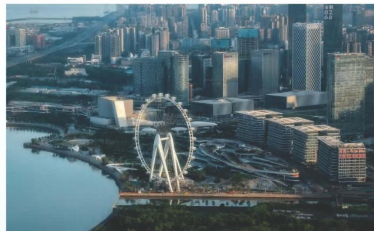
滨海文化公园基坑支护工程
