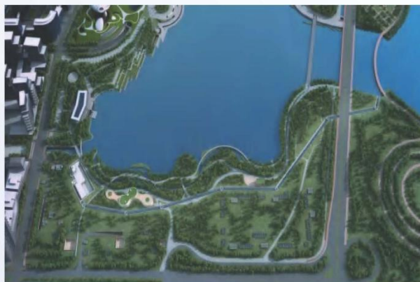
后海河调蓄池工程
