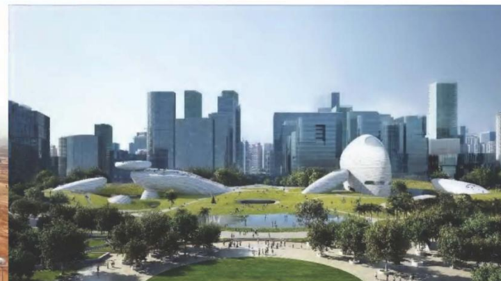
基坑、桩基与土石方工程-深圳湾文化广场项目
