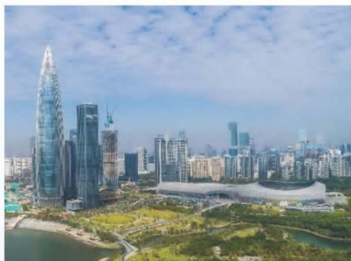
基坑监测-深圳湾体育中心、中国华润大厦基坑监测工程
