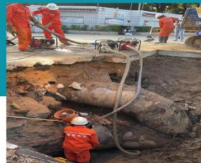
燕罗水厂内DN1000三通 钢管爆裂抢修
