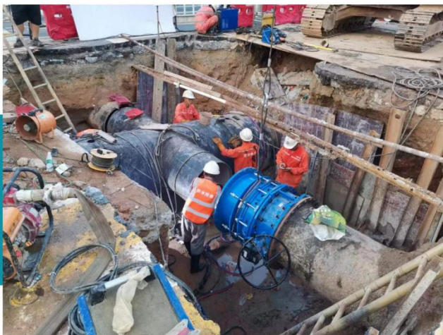
2020，松岗东方大道，DN1400、DN800、DN1000四通 口接驳碰口、更换DN1000蝶阀
