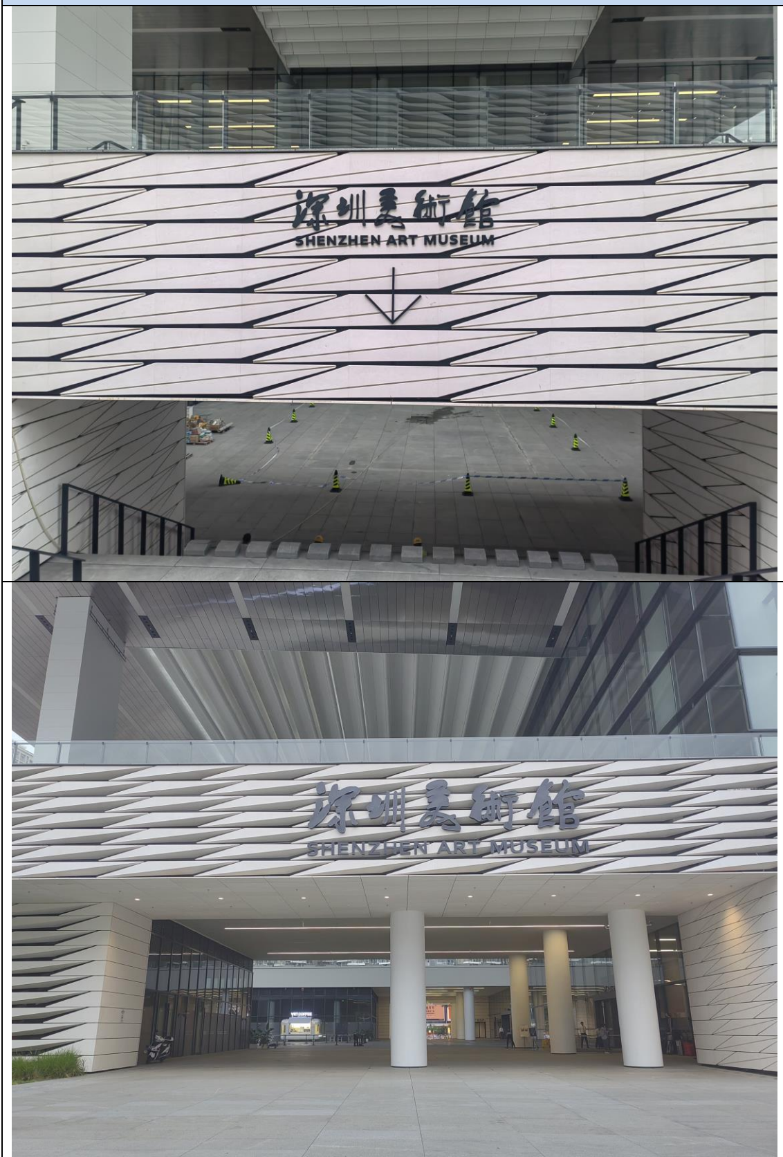
深圳美术馆新馆深圳第二图书馆项目装修装饰 II 标段项目一项目实景照片
