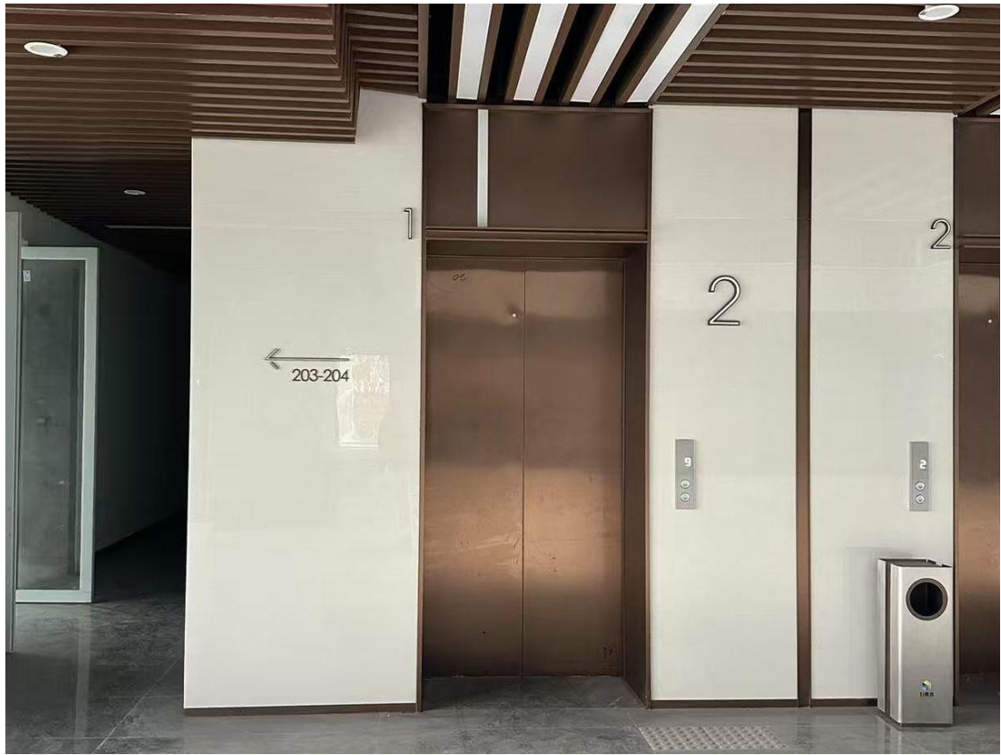
白鹭湾科技生态园 3 号地建设项目标识标牌工程一项目实景照片
