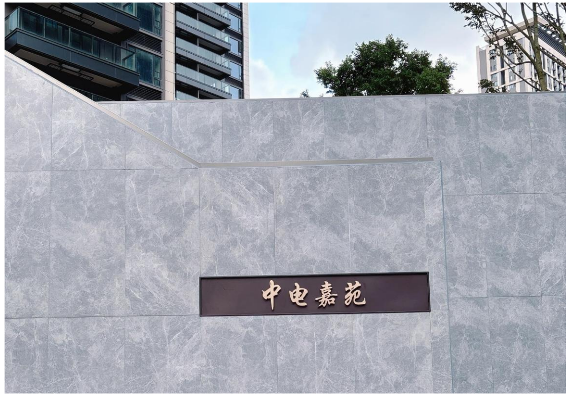
中电创新大厦项目及中电嘉苑项目标识工程—项目实景照片
