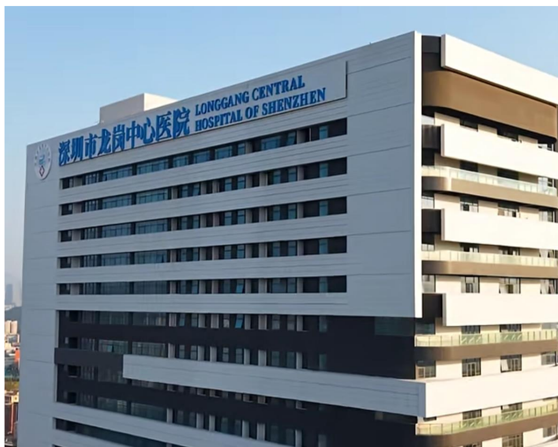
龙岗中心医院外科综合楼工程标识标牌系统采购及安装—项目实景照片
