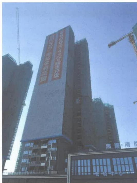
施工中外墙脚手架按规范搭设，立面整洁
