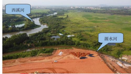
4号桥（跨越源水河）桥位处现场照片
