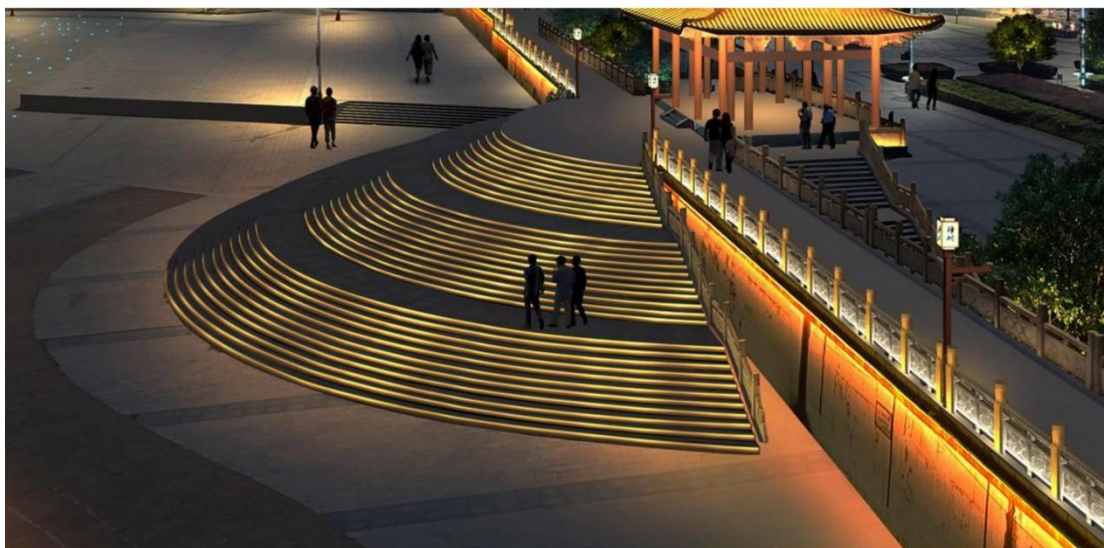
效果展示——防洪城墙
