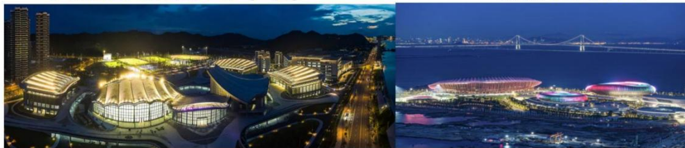
汕头亚青会主场馆项目、游泳跳水馆改建项目
