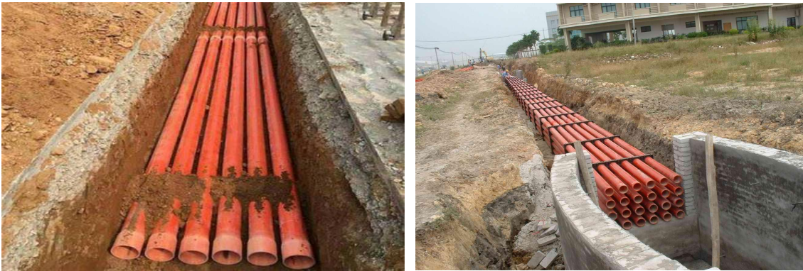
电缆保护管安装示意图
