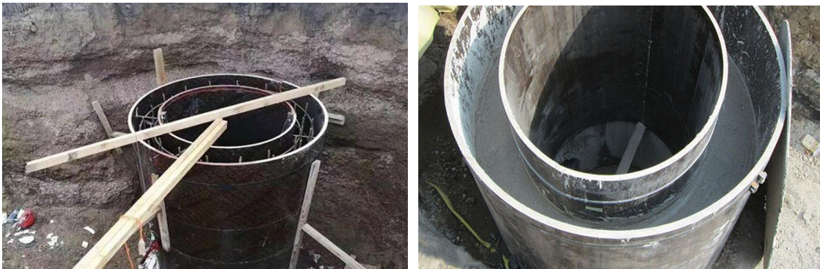
混凝土检查井模板安装示意图
