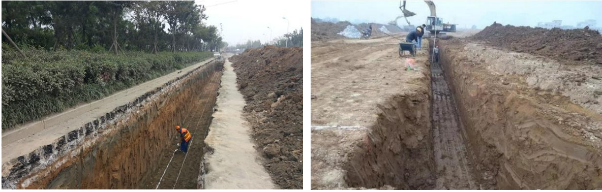
沟槽开挖示意图
