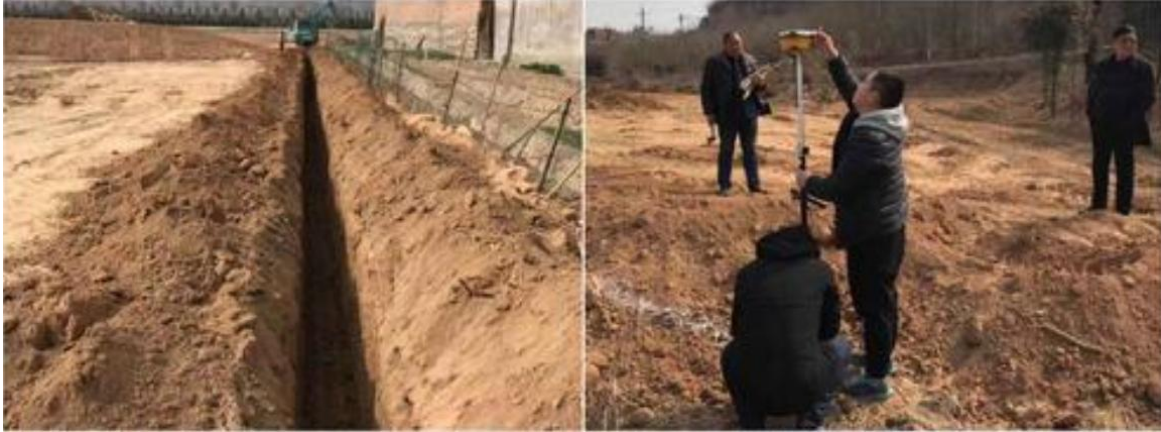
管沟开挖示意图
