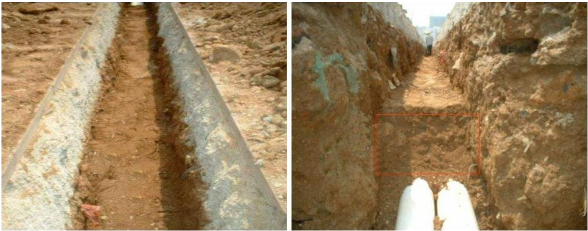
通信管沟回填示意图
