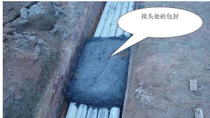
管道接头包封示意图
