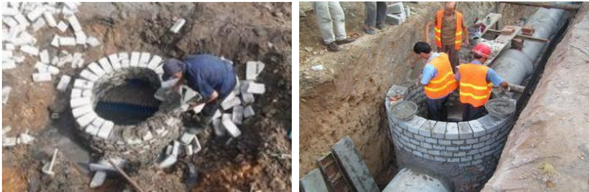
砌筑井施工示意图
