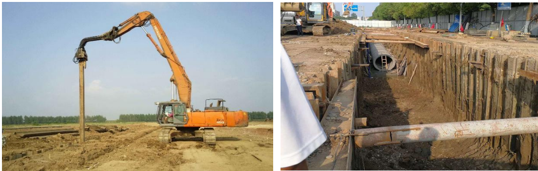
板桩施工示意图
