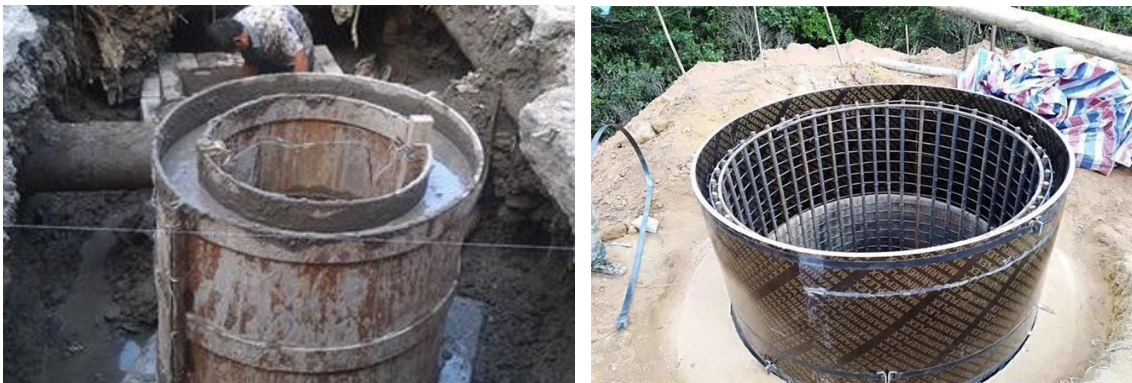
混凝土检查井施工示意图
