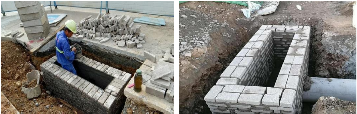
雨水口施工示意图
