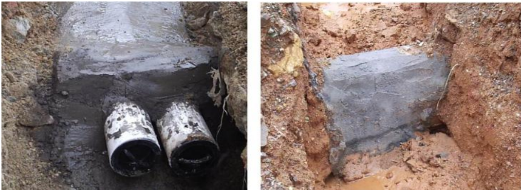
管道包封施工示意图
