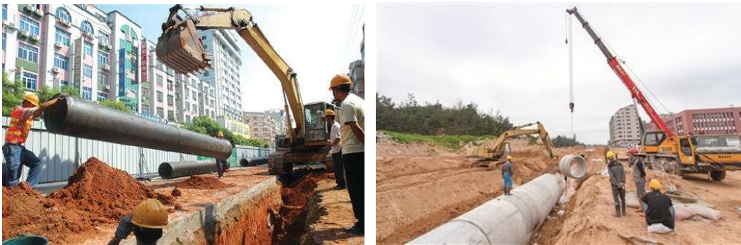
管道吊装示意图
