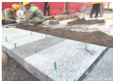
石材三线法铺装
