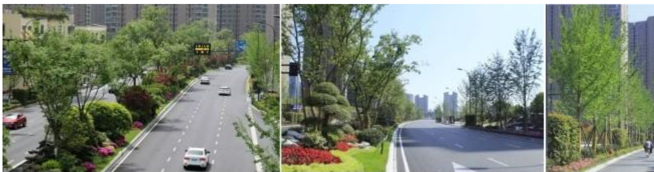
图 1-16 杭州 2016 年城市更新项目
