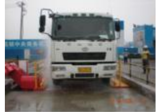
设置机动车辆冲洗设施
