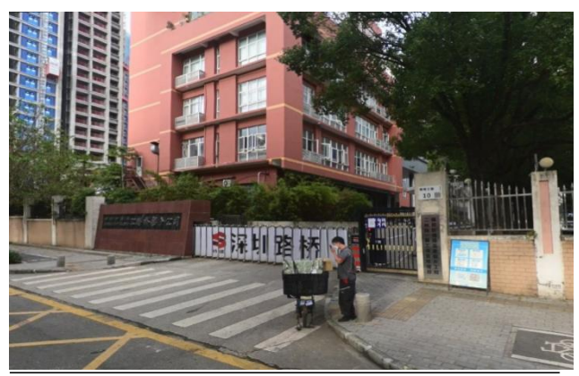
南山桥梁标养护基地
