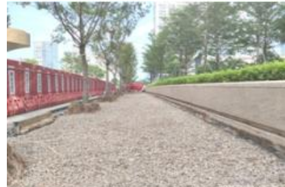
级配碎石施工
