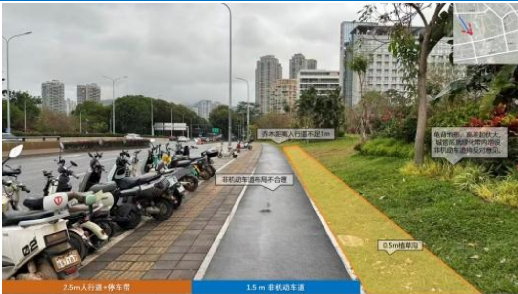
香蜜湖路东侧（深圳国际交流中心西门出入口-熙园北门出入口）人行道现状
