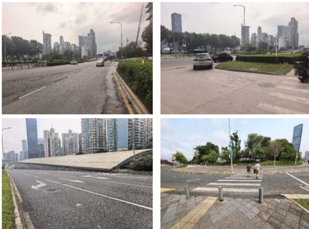
机动车道路面现状
