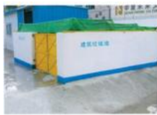
建筑垃圾、渣土定点堆放
