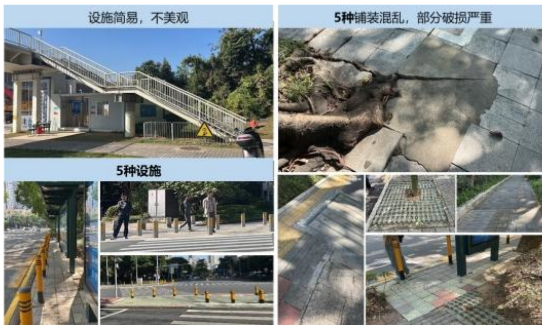
人行道铺装现状
