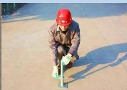
第二步：现场定位放线
