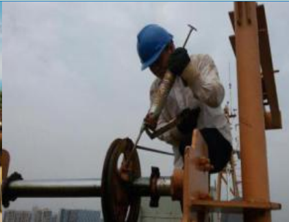
塔吊定期维修保养
