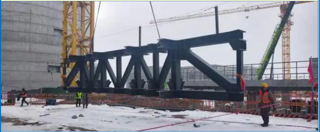
钢结构吊装示意图
