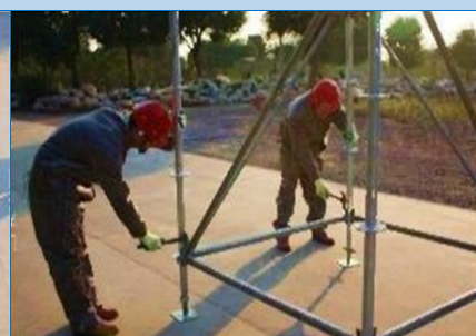
第三步：第一步架体安装
