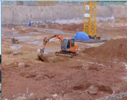
小挖机开挖承台
