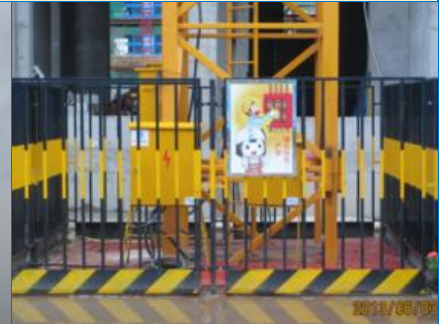
塔吊穿楼板封闭围挡
