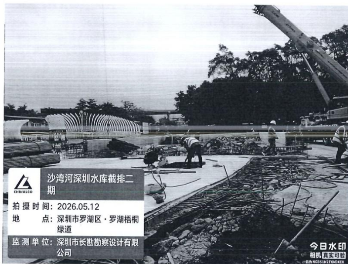
盾构始发井现状照片
