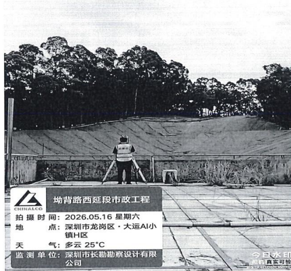
监测及巡视照片
