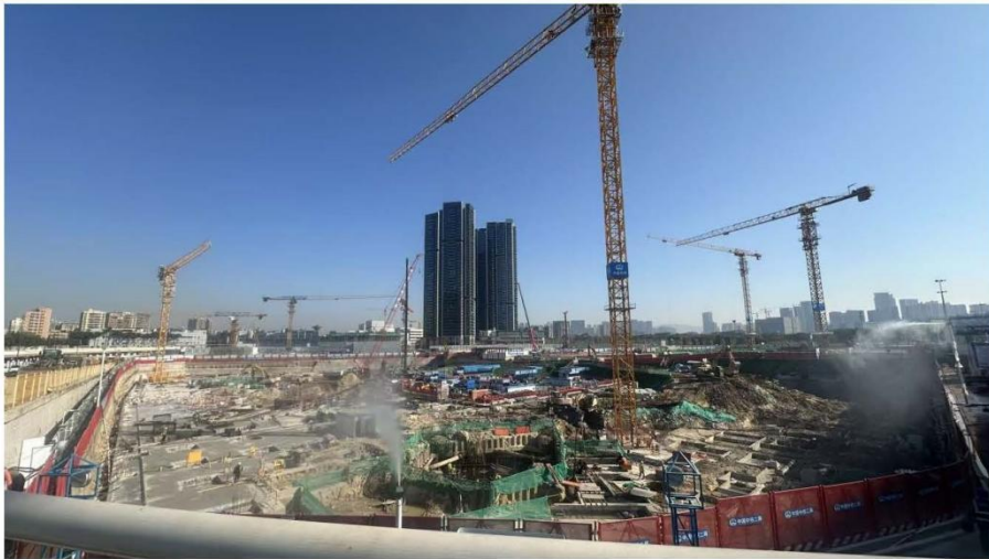
图 1 项目施工近况图
