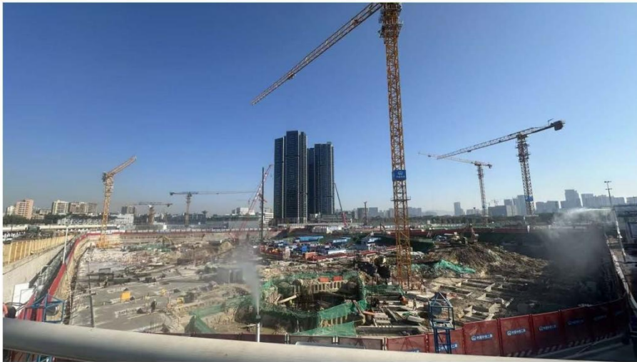
图 1 项目施工近况图
