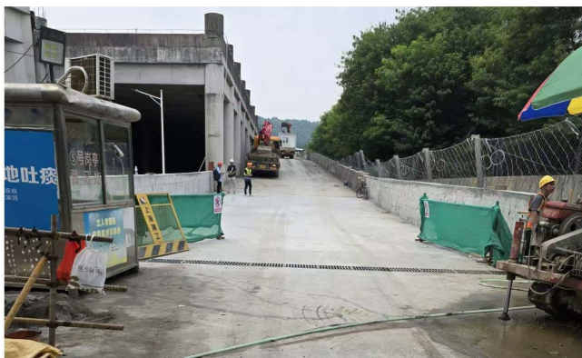
图 1 项目施工近况图
