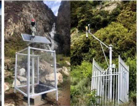
西藏林芝市专群结合监测预警监测站建设项目
