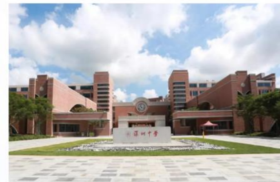
基坑监测-深圳中学（泥岗校区）建设工程项目
