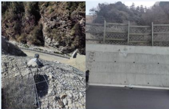
西藏亚东县LMP抵边通外道路K1+600处应急抢险灾害治理工程
