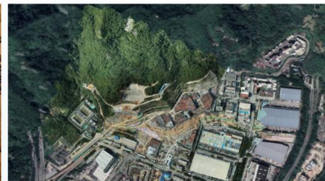
应急监测-盐田港拖车综合服务中心建设工程边坡应急监测项目
