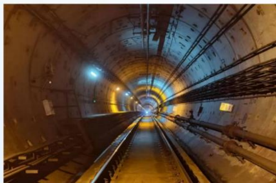
基坑监测-深圳地铁运营监测
