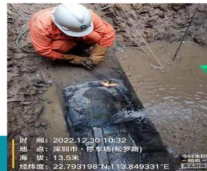
DN1000钢管爆裂抢修
