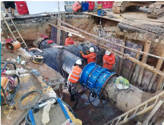
2020，松岗东方大道，DN1400、DN800、DN1000四通 口接驳碰口、更换DN1000蝶阀
