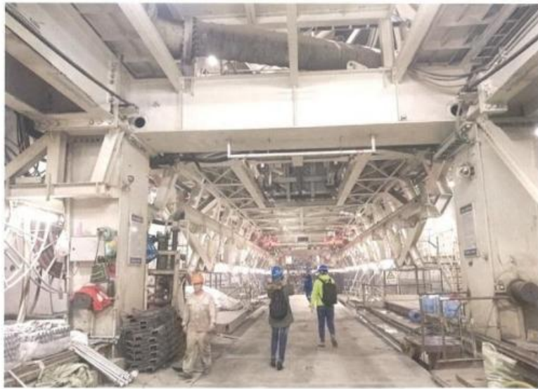
项目审核人员参观上海沿江通道越江隧道
