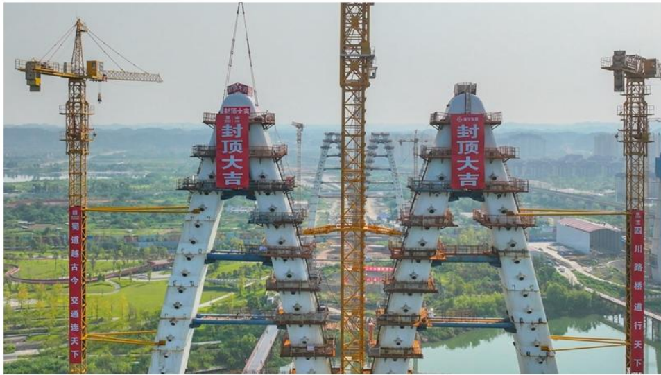
遂宁市涪江六桥主塔顺利封顶。（四川省交通运输厅供图）
