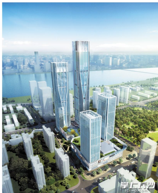
作为长沙河西第一高楼的滨江国际金融中心T1塔楼已开始桩基施工。图为滨江国际金融中心鸟瞰效果图。资料图片
