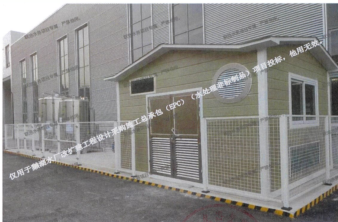
集中供气房（氮气、氩气、二氧化碳、压缩空气）
