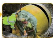
11 管口切割处理
