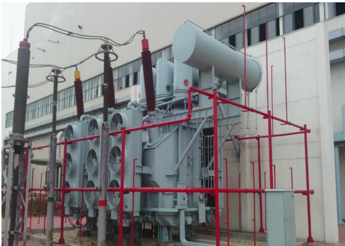
SFP10-400000/220 型变压器
