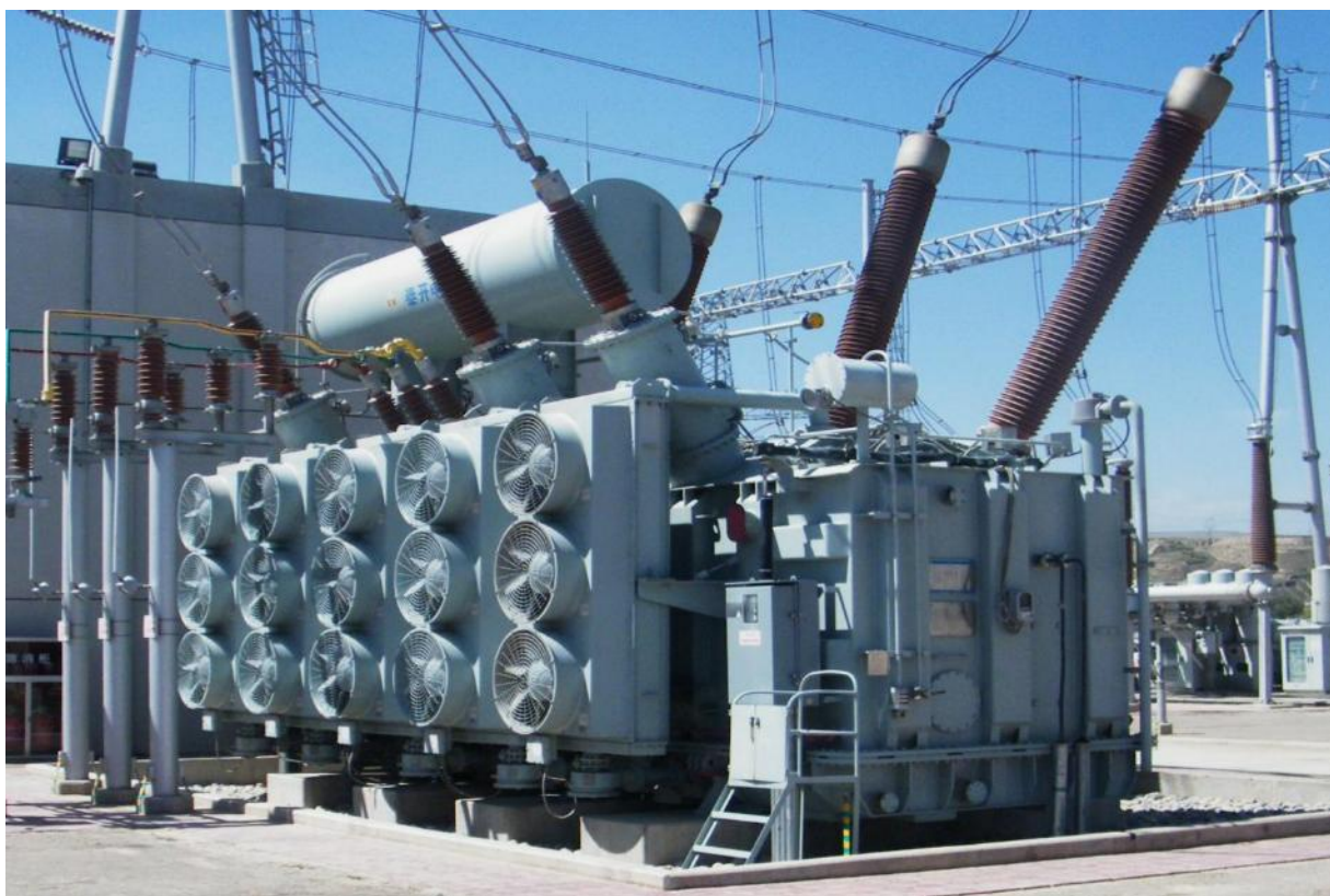
SFP10-400000/220 型变压器
