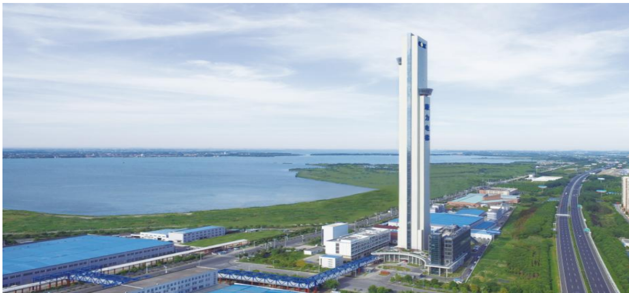
全球超高288米电梯试验塔及企业技术中心
