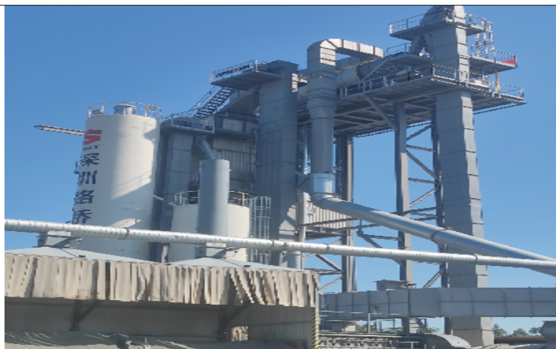
深圳路桥东部公司惠州搅拌站
