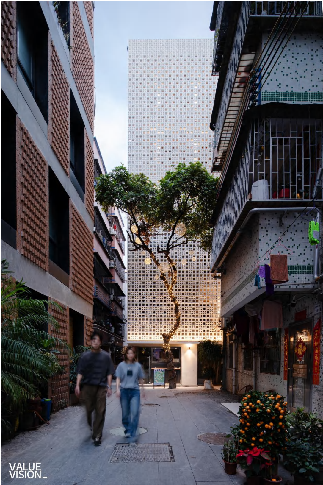
南头二期改造楼栋实景图
