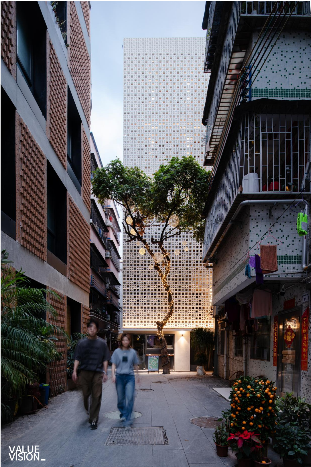
南头二期改造楼栋实景图
