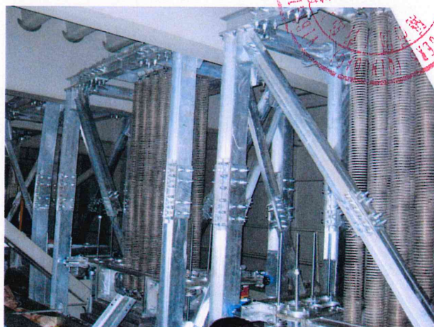
TMD 频率约 0.5Hz，质量 3.6 吨
