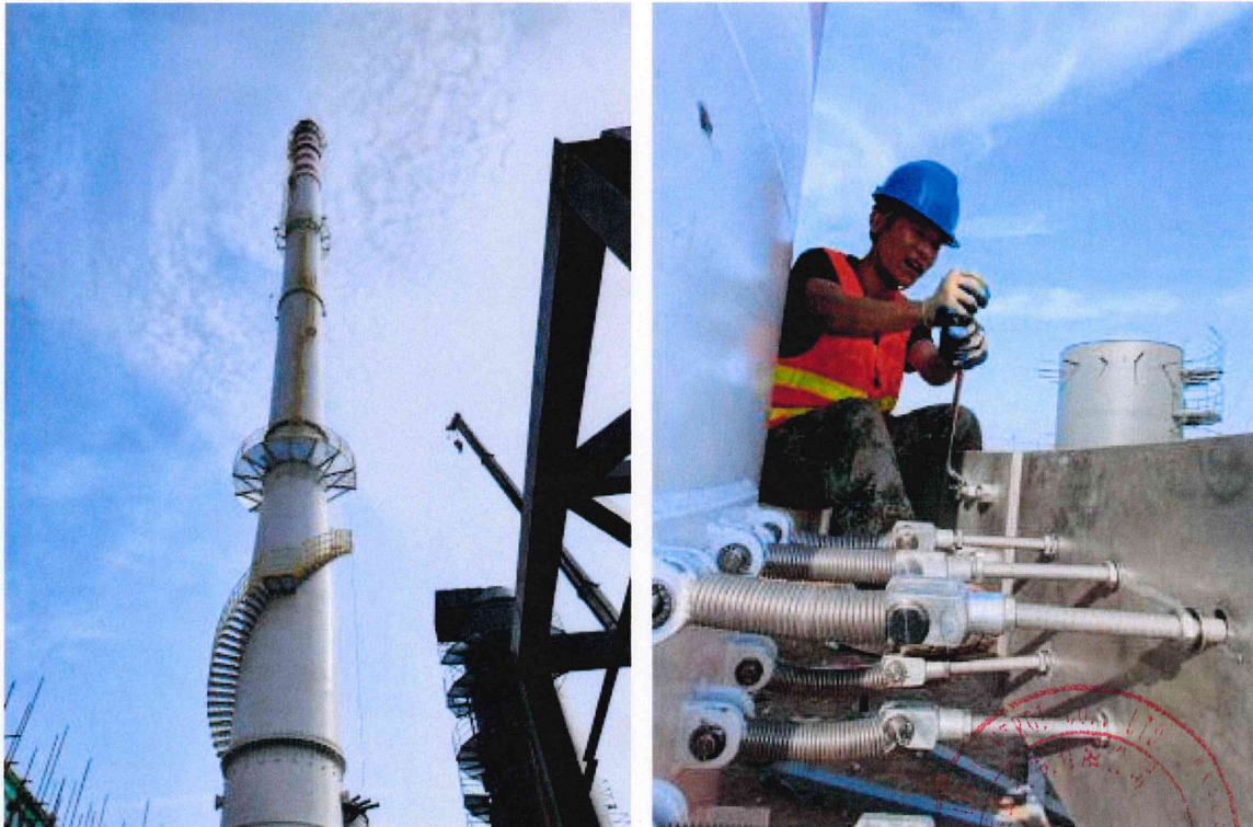
TMD 安装调试现场图片
