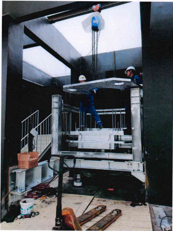
TMD 安装照片
