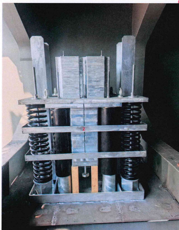
TMD 现场安装照片
