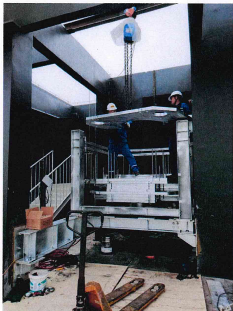
TMD 安装照片
