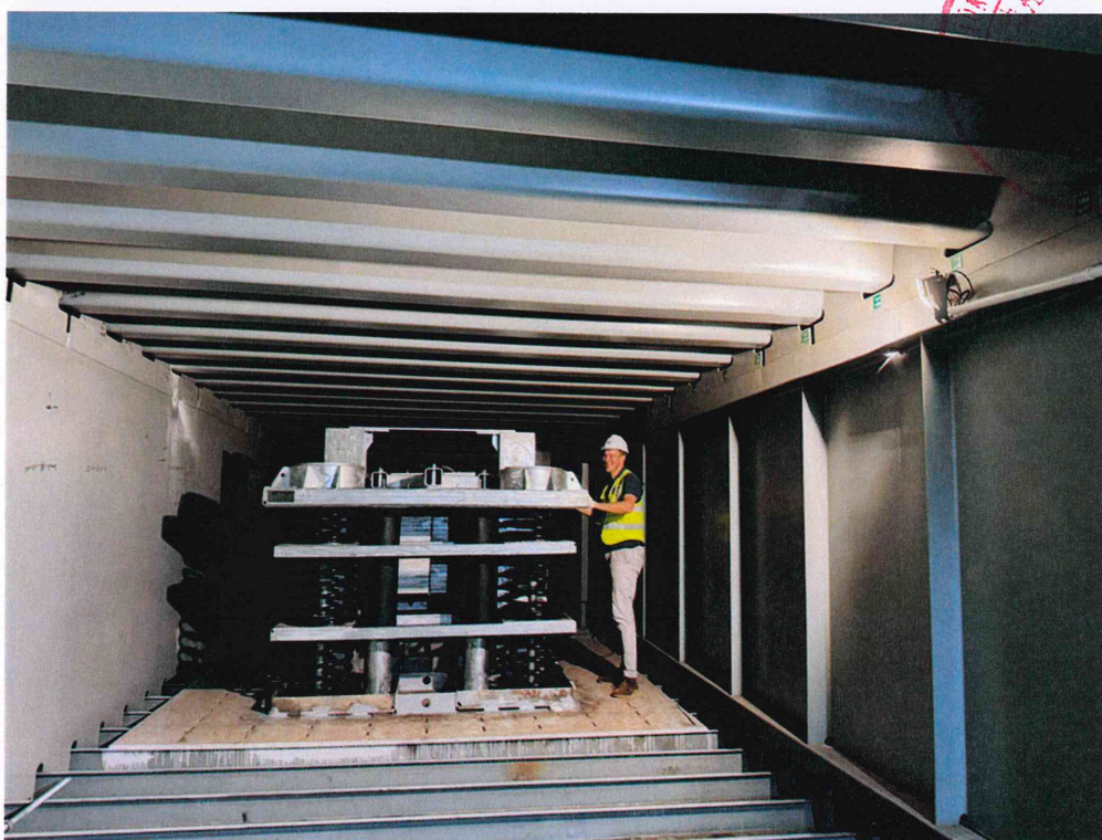
0.36Hz 的 TMD 现场照片
