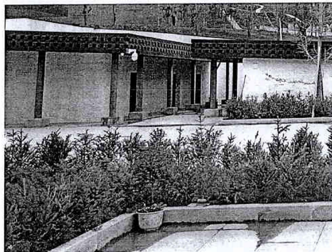
19. 现场卫生清理情况较差, 需再清理。已整改。
