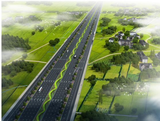
成德大道北延线(成都段)项目一期工程
