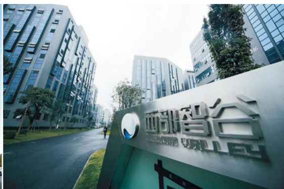
武侯工业园西部智谷建设项目
