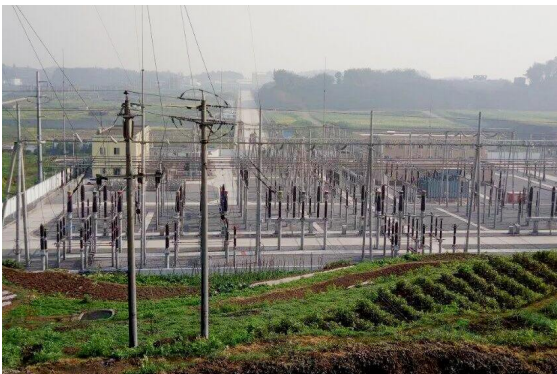
余箐 110kV 变电站升压技改工程
