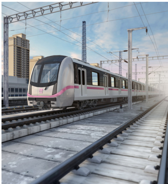
「陕西，西安 西安市地铁8号线、10号线、15号线一期工程
