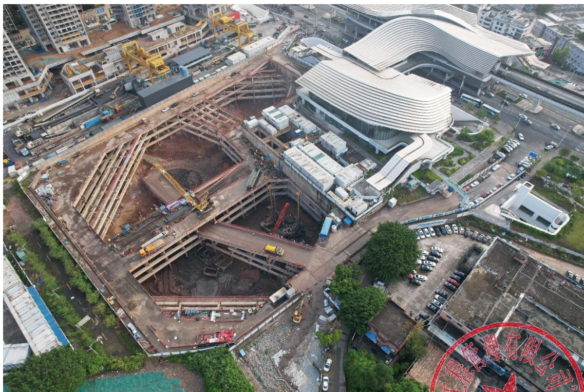
实景图 北地块航拍图
