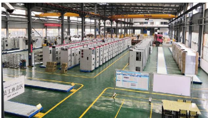
电力产品装备现场
