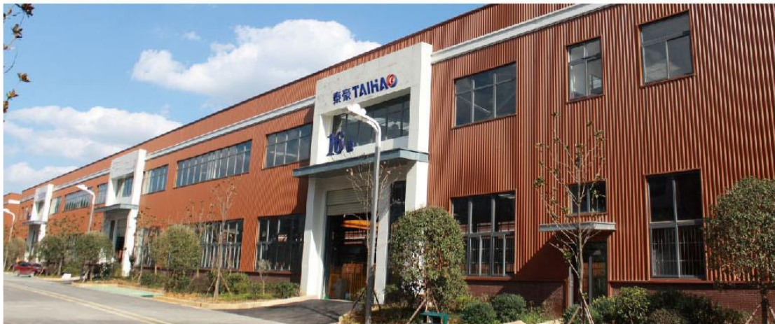
贵州电气工业园生产基地车间外景
