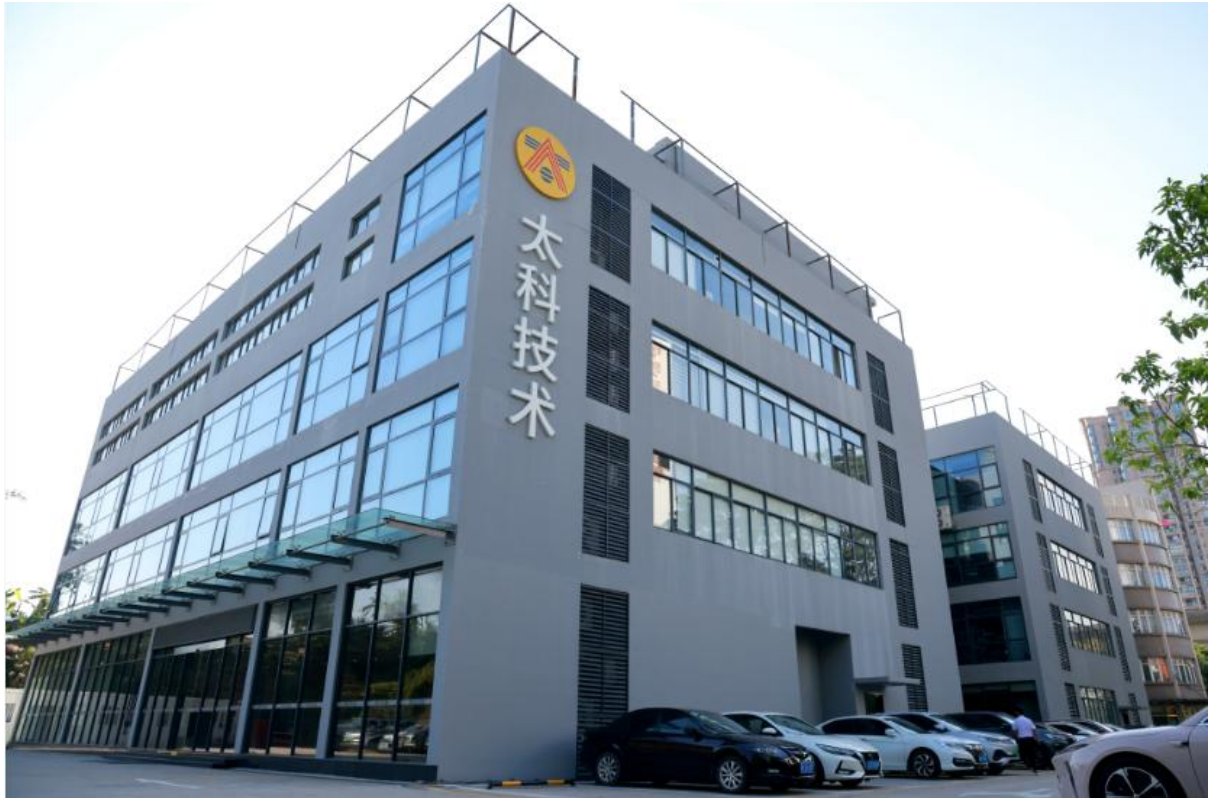
太科技术有限公司-东部技术中心
