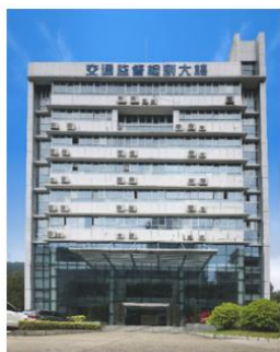
总部：交通监督检测大楼 (2700 m 2 )
