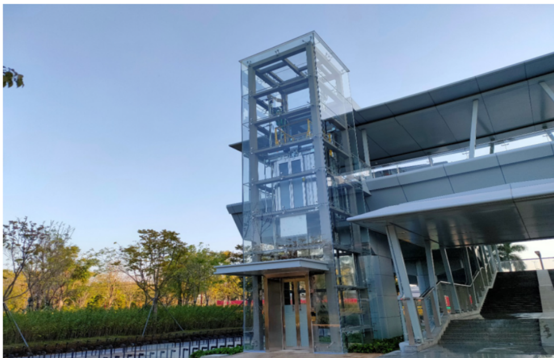
沙河西大冲人行天桥竣工实景图
