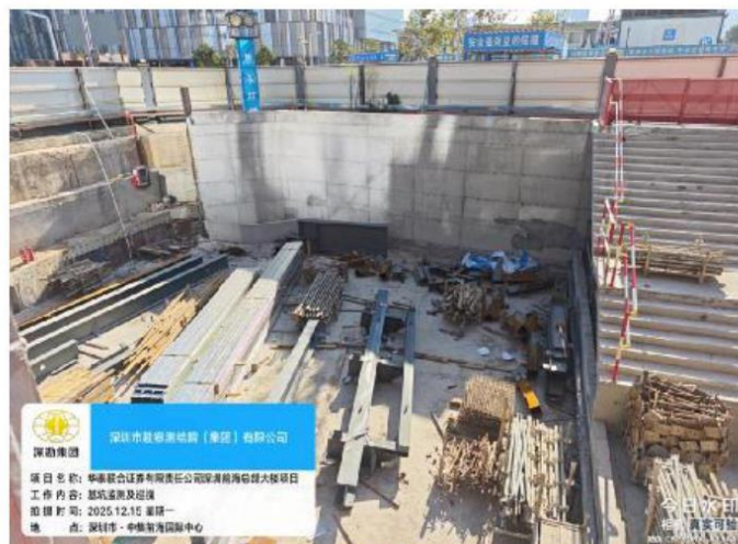
图 1.1 基坑东侧现状图（拍摄于 2025 年 12 月 15 日）
