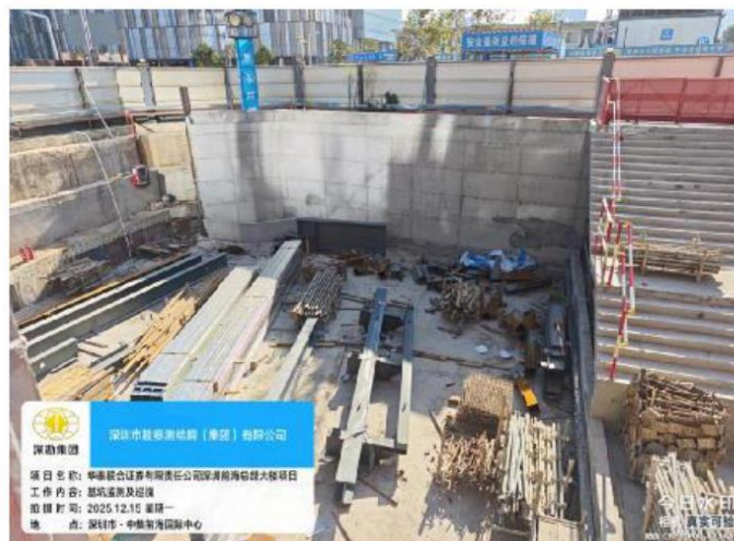
图 1.1 基坑东侧现状图（拍摄于 2025 年 12 月 15 日）
