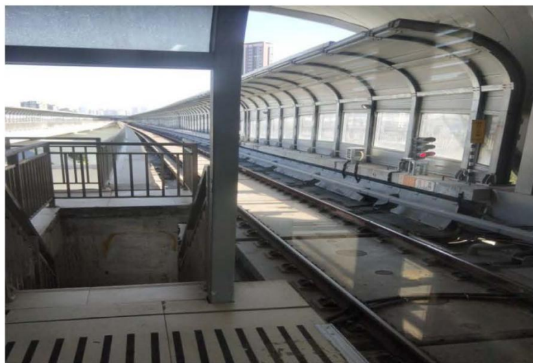
地铁现场实景
