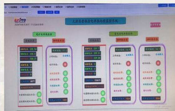
尾矿输送管道电伴热保温工程
