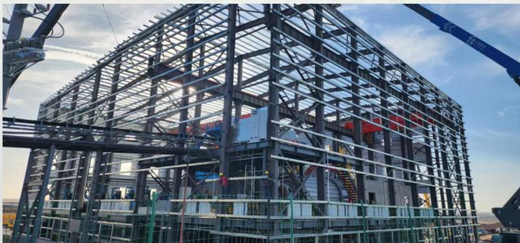
昶泰矿业钢结构选矿车间系统优化改造项目
