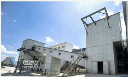
新疆金川矿业筛分车间钢结构厂房
