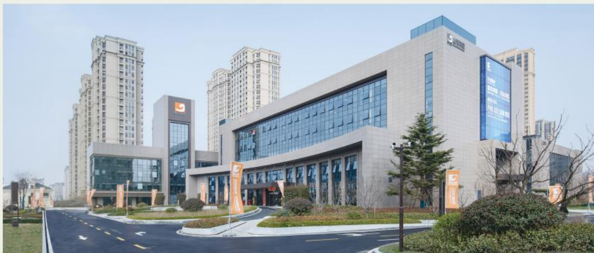
山东黄金集团新办公楼改造扩建总承包
