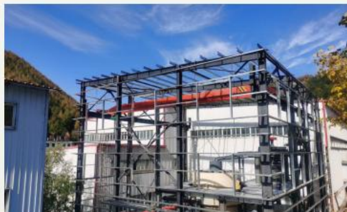
西和中宝矿业钢结构厂房
