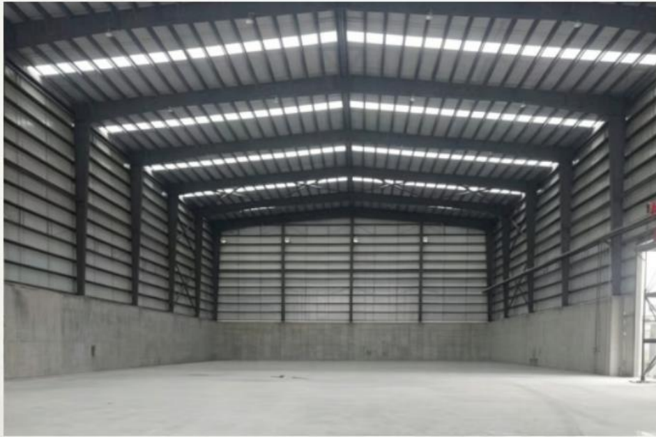
新城金矿矿石堆场钢结构厂房
