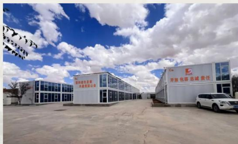
昶泰矿业陶勒盖金矿集装箱宿舍
