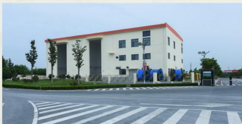
焦家金矿 35KV 变电站土建工程
