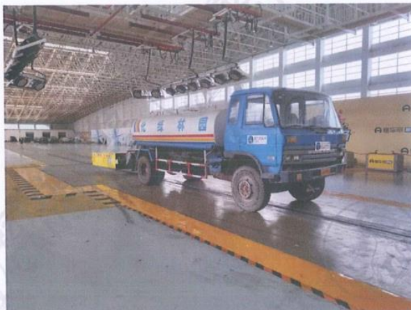
图 3 试验前车及试件的安装
