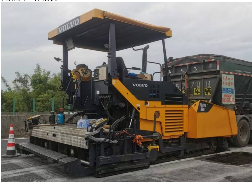
设备照片(摊铺机)
