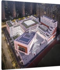
奉贤区致远高中迁建工程
