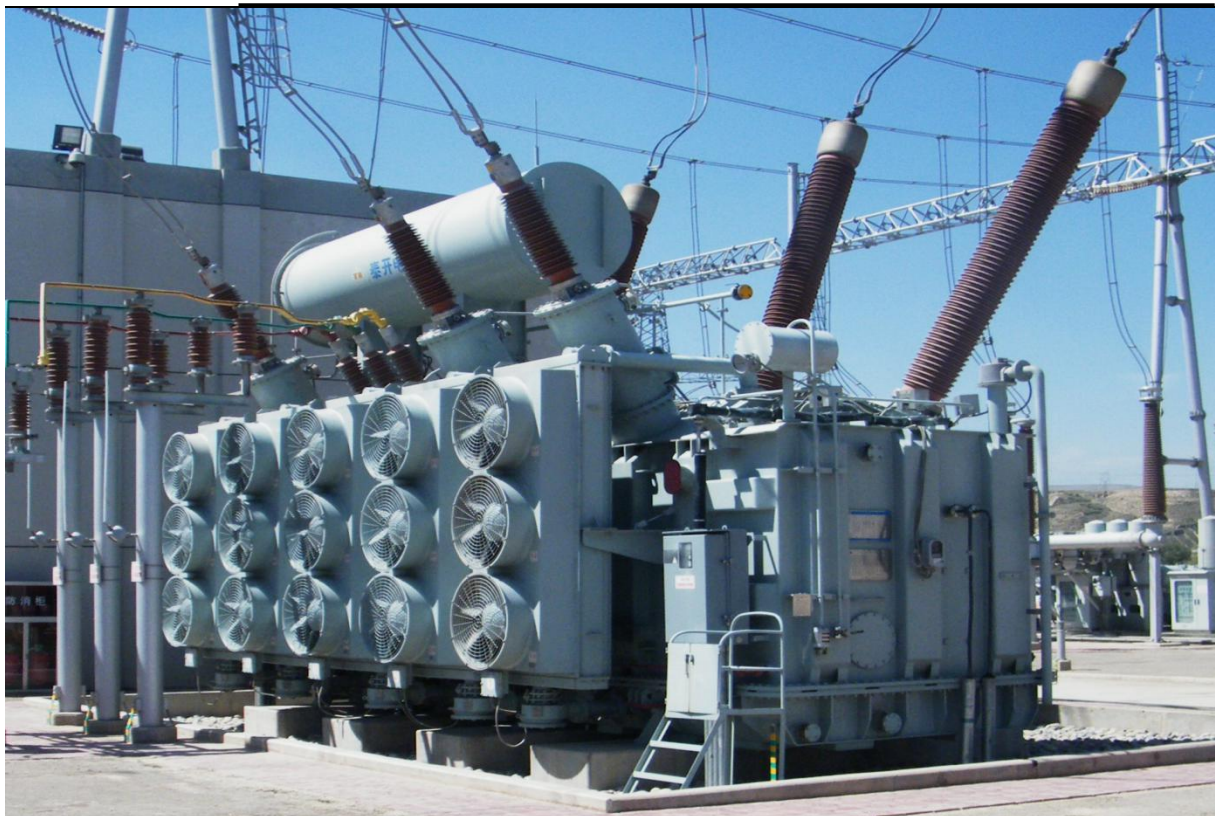
SFP10-400000/220 型变压器
