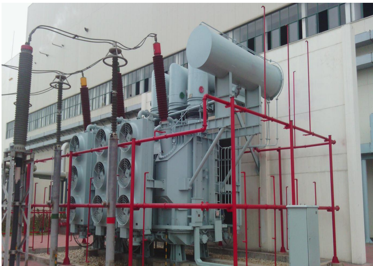
国内首台 SSZ13-240000/220 型超级节能变压器
