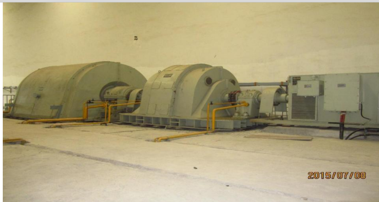
30000kVA 工频发电机组
