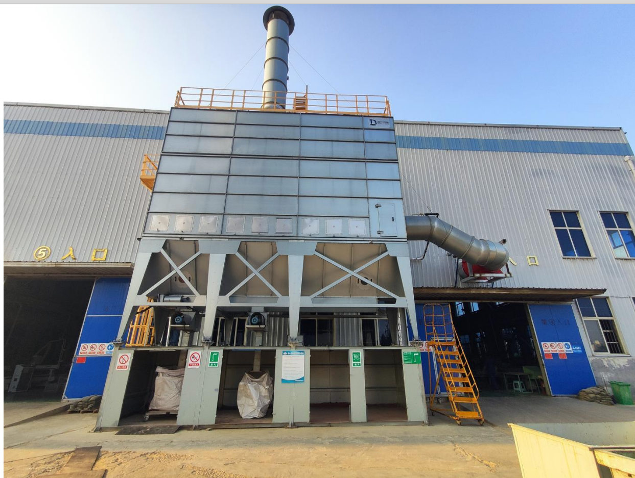
绝缘车间集中除尘装置
