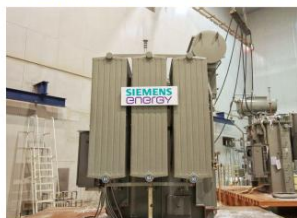
四川江油换流变压器32.2MVA/10kV
