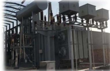
国内首台 110kV 自励磁式磁控电抗器
