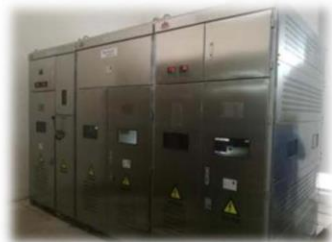
国内最大容量（ 100Mvar ）快速励磁电抗器（海 拔 4000 米）— 国网科技示范项目
