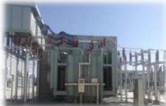
国内最大容量（ 100Mvar ）快速励磁电抗器（海 拔 4000 米）— 国网科技示范项目
