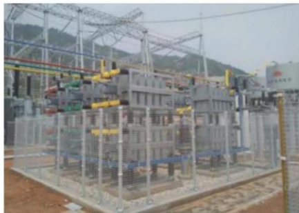
福建厦门厦东 500kV 变电站用 TBB
