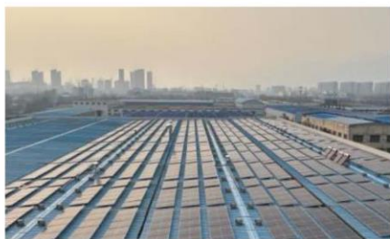
3.6MW 厂区屋顶光伏发电
