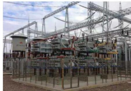
新疆五彩湾站 66kV/90M 电容器成套
