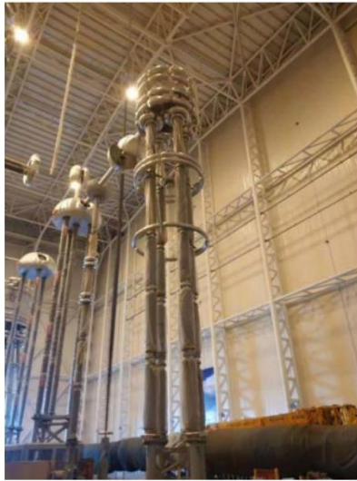
±1100kV 昌吉换流站工程±1100kVPLC 现场安装图
