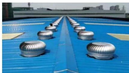
无动力风帽空气循环系统
