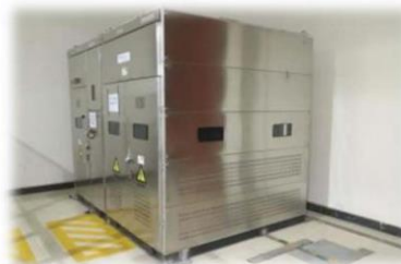
国内首台 110kV 自励磁式磁控电抗器
