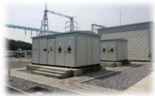
户外箱体式消弧线圈成套装置（环境温度 45℃）
