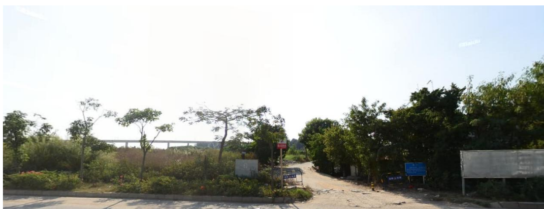
东海堤跨海大桥现状
