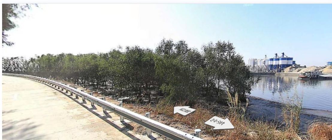
东海堤连接线栈桥现状
