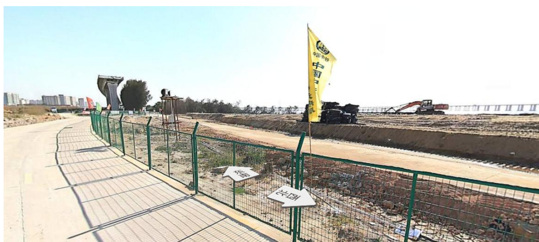
西海堤连接线陆域现状
