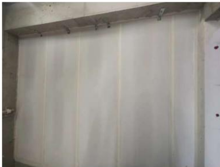
图 4.3.4-1 墙板拼装完成图
