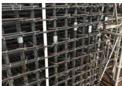
高强钢筋直螺纹连接
